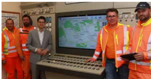
Die Fachkraft für Wasserversorgungstechnik, Christian Nachlinger (v. r.) und Abwassermeister Jürgen Murr präsentierten Bürgermeister Martin Pichler Prozessleitsystem und Meldungen auf mobile Systeme, die schnelle Reaktionen von Christian Hölzlwimmer als Fachkraft für Abwassertechnik und Georg Braumandl auch aus Bereitschaftsdienst anstoßen, wenn sie benötigt werden. Foto: Markt Schönberg
