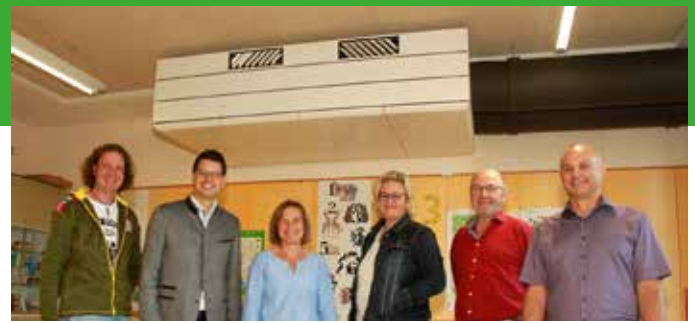
Planer Christian Friedl (v.l.) erläuterte Hausmeister Josef Uhrmann, Gemeinderätin Carolin Garhammer, Schulleiterin Roswitha Bumberger, Bürgermeister Martin Pichler und Markus Christoph vom Bauamt Schönberg Funktion und Vorteile der fertiggestellten Lüftungsanlage.
