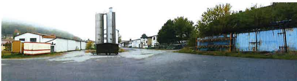
Abb. 34: Standort 01- Ehemaliges Gelände der Fa. Bolta
