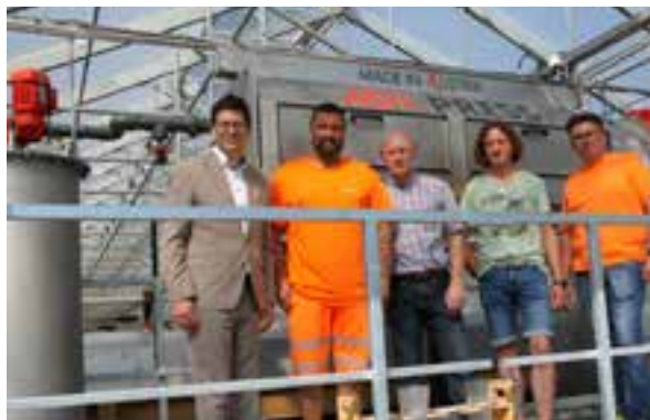
An der Schneckenpresse der solaren Klärschlamm-trocknungsanlage des Marktes Schönberg trafen sich Bürgermeister Martin Pichler (v.l.), Klärwärter Christian Hölzlwimmer, Gemeinderat Horst Jäger sowie vom Bauamt Markus Christoph und Jürgen Murr. Was von der Investition hinten raus kommt, soll sich im Geldbeutel des Bürgers auf mittlere Sicht sehen lassen können. Foto: Markt Schönberg
