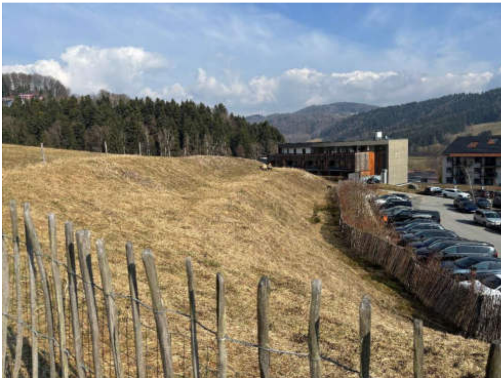
Abb. 3: Blick nach Norden – Böschung entlang Parkplatz; Foto Jocham Kessler Kellhuber (März 2026)
